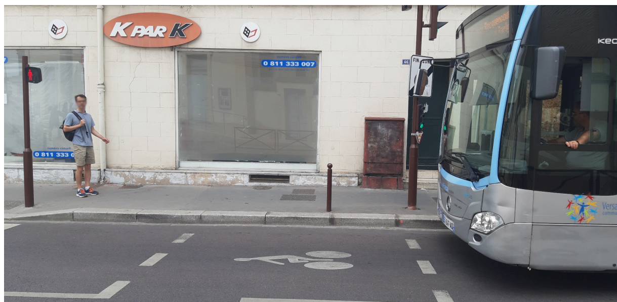
Exemple d'un aménagement cyclable incohérent, rue de Vergennes : le sas vélo est après le feu...
